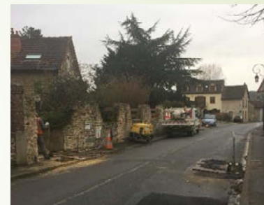
Hiver 2017 -Fin de chantier eau potable (suppression du plomb)
