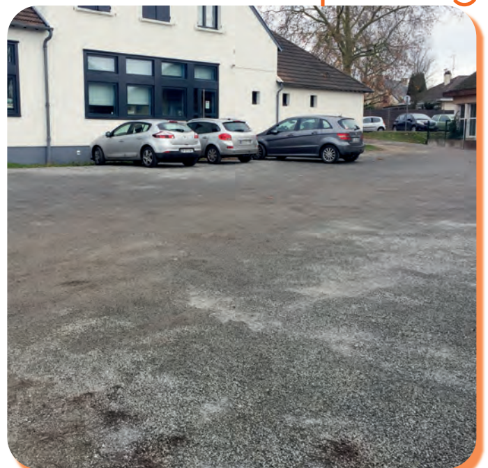
Réfection du parking à l'arrière de l'école Jean JAURÈS.
