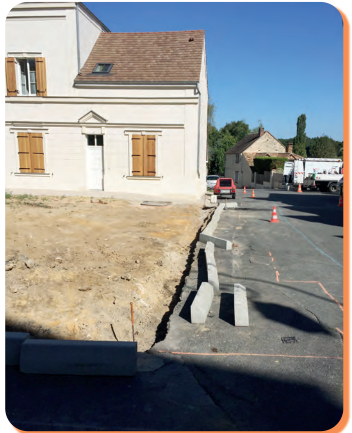
Réfection voirie place de Newick.
